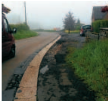
Des travaux à prévoir
