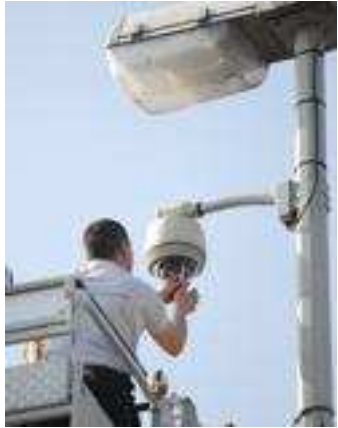
Installation postposée pour Herve.
